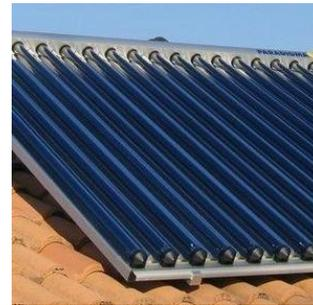
→ Utilise l'énergie thermique du rayonnement solaire pour chauffer un fluide (souvent de l'eau)
