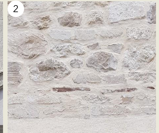
Façade en moellons apparents
