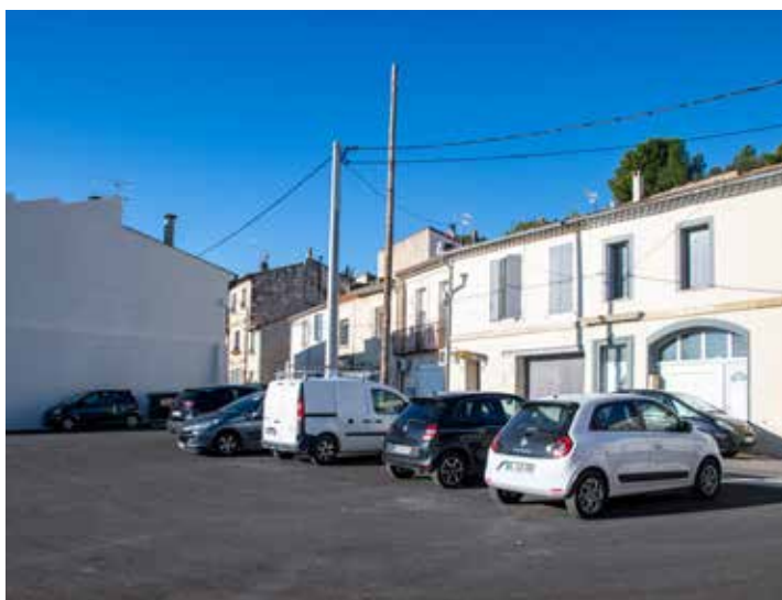
Fin des travaux du parking en centre-ville de Bellegarde
