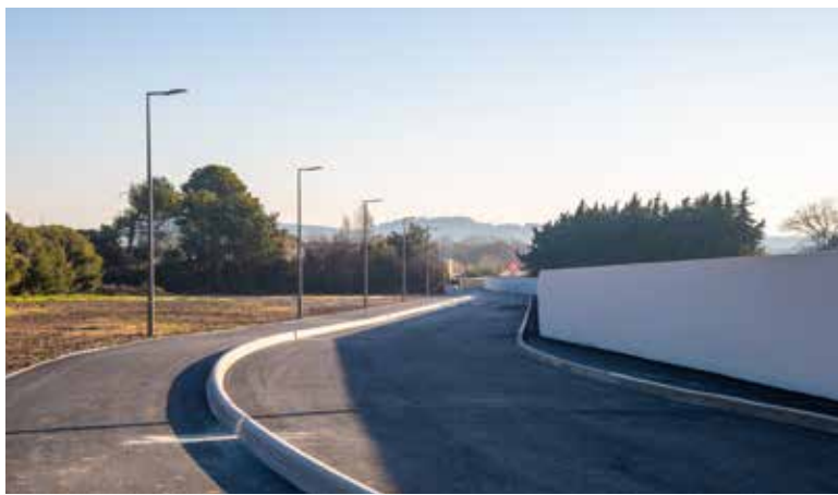
Réalisation d'une déviation à Jonquières-Saint-Vincent
