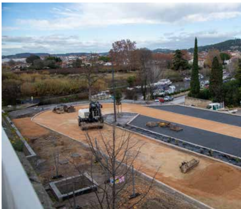
Avancement des travaux au Pôle Multimodal - Beaucaire
