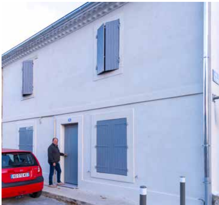
Rénovation de façade dans le cadre de l'Opération Rénov'façade - Bellegarde
