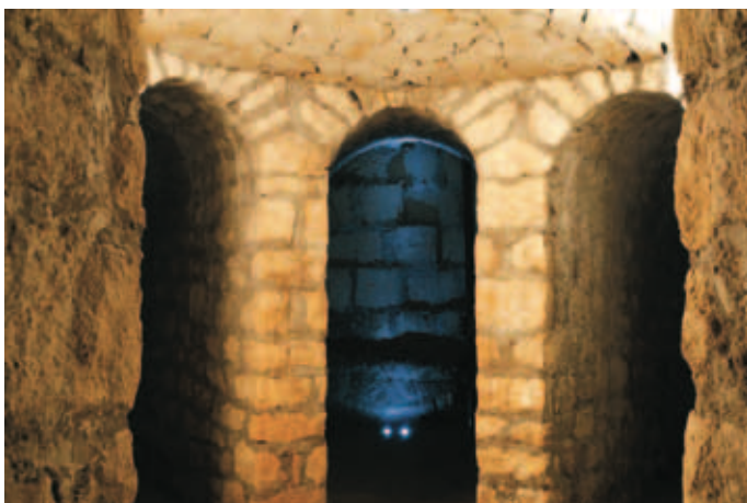
Intérieur du château d'eau de Fourques rénové
