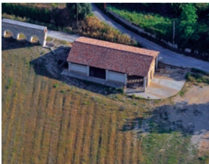
Future aire de covoiturage de Bellegarde
