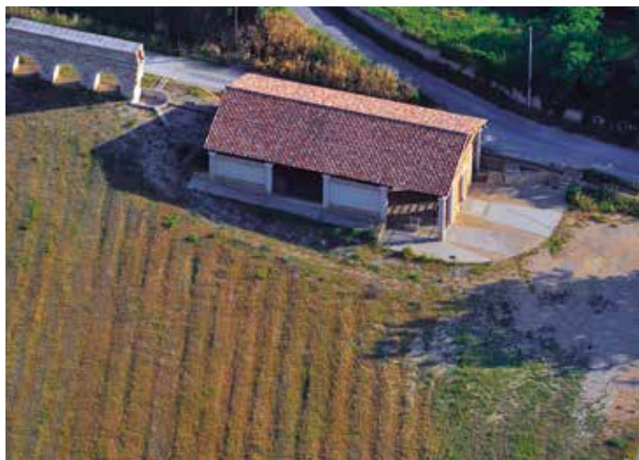
Future aire de covoiturage de Bellegarde
